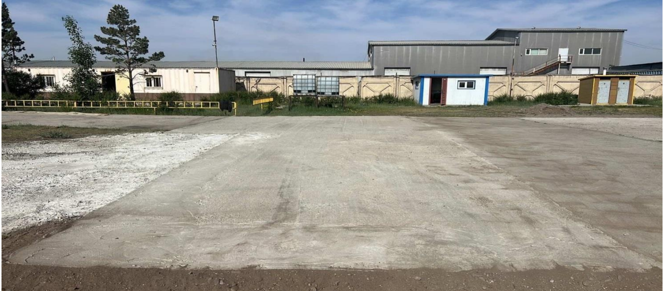
Зураг 4. Хөрс бетонжуулалт
